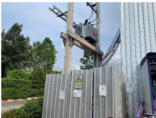
รูปที่ 47 หม้อแปลงไฟฟ้าของโครงการและตู้ไฟฟ้าชั่วคราว
