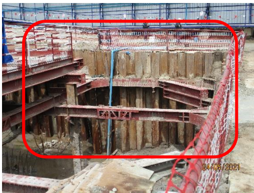
รูปที่ 18 การติดตั้ง Sheet Pile
